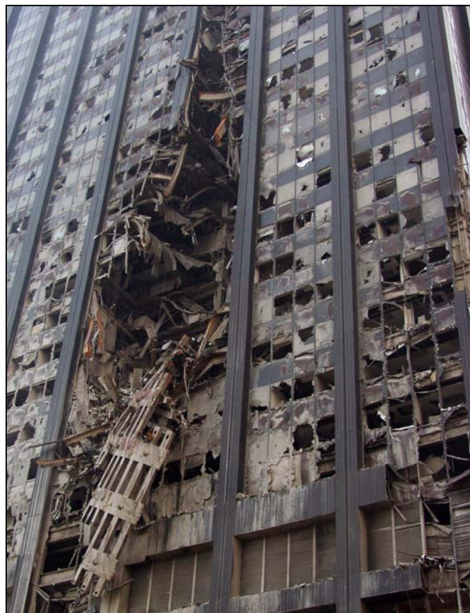
Nowy Jork, 21 września 2001 – budynek w pobliżu World Trade Center został poważnie uszkodzony w wyniku ataku terrorystycznego. Zdjęcie: Michael Rieger/ FEMA News Photo
